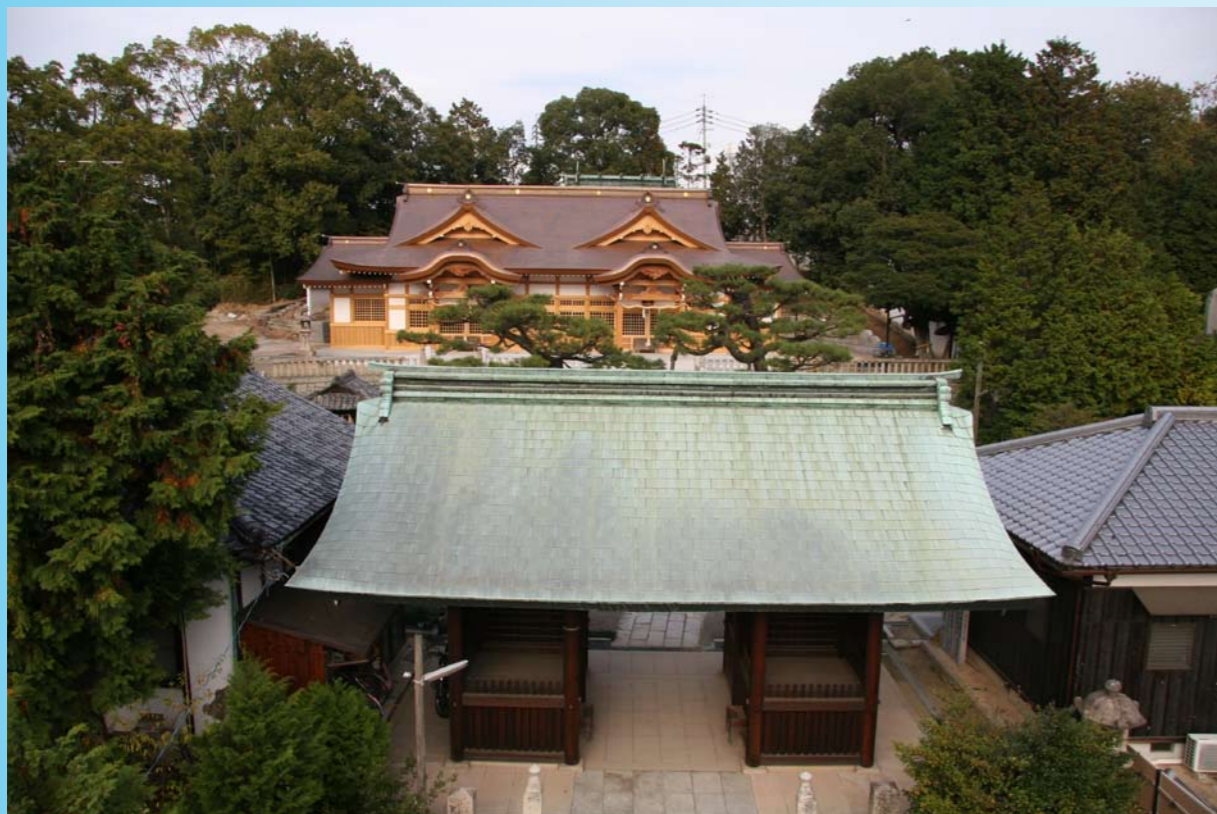
正面随神門越しに社殿を望む（平成 21 年 11 月）
