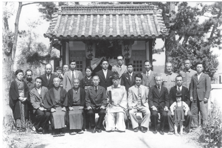
河内神社社殿修理落成記念(昭和28年5月18日)
