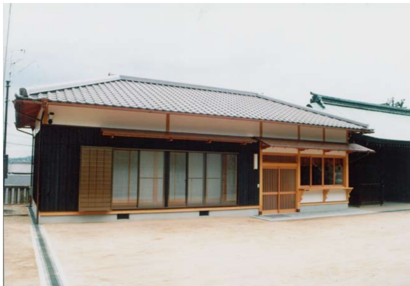
移して改築された社務所（平成10年9月）
