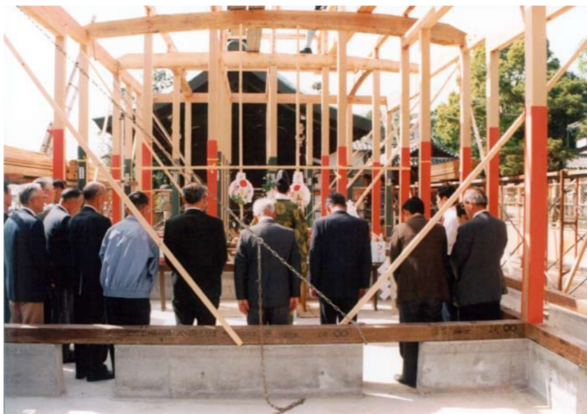
社務所上棟祭（平成10年4月19日）
