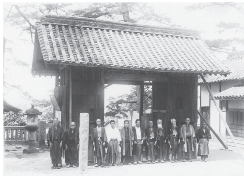
随神門解体直前（昭和7年8月10日）
