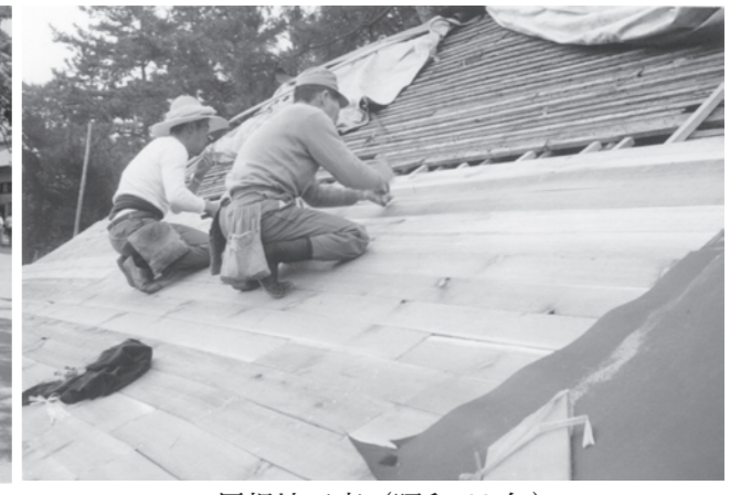
屋根地工事(昭和46年)
