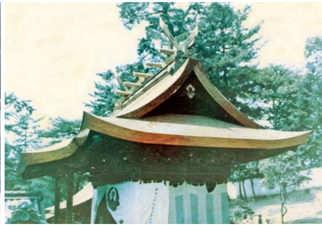
銅板の葺き替えが完了した鶴崎神社本殿(昭和46年)
