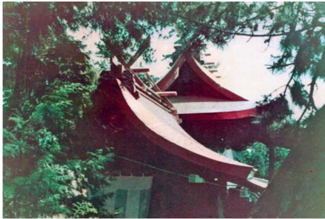
銅板の葺き替えが完了した八幡神社本殿(昭和46年)
