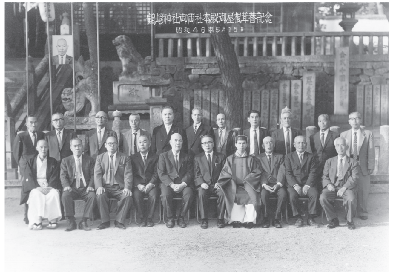
鶴崎神社・八幡神社両社本殿屋根銅板葺き替え記念(昭和46年5月15日)
