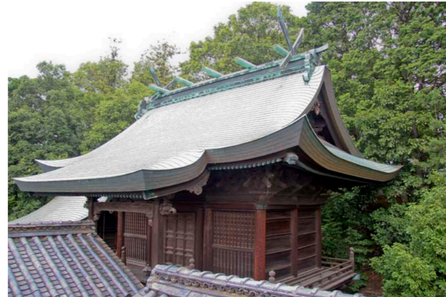
入母屋造りの本殿
