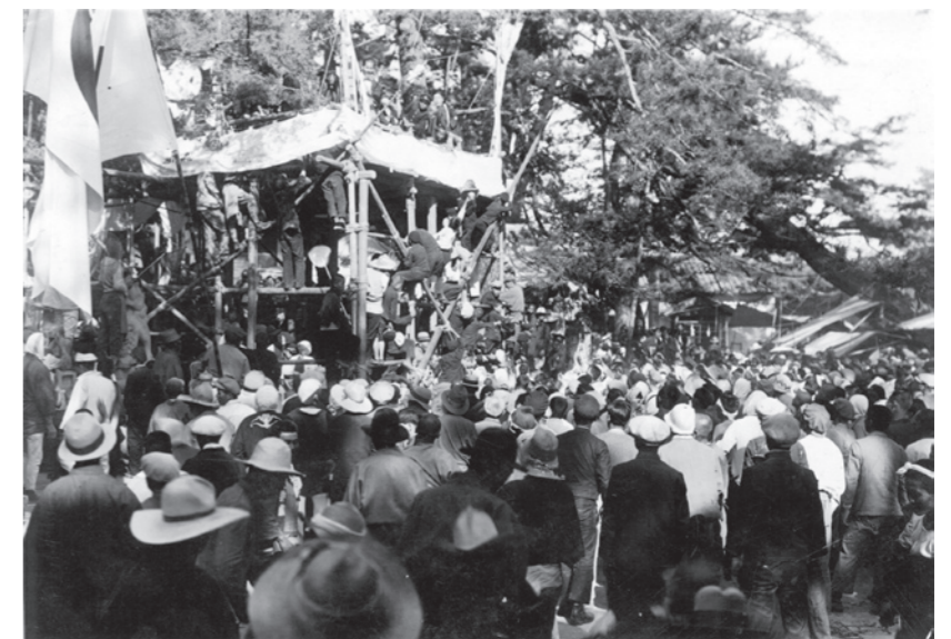
本殿屋根 (檜皮葺き) 葺き替え竣工奉祝祭 (大正15年)
