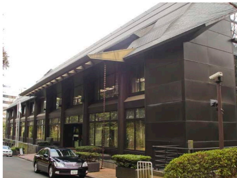
昭和 62 年明治神宮北参道入り口に建設、移転した神社本庁
