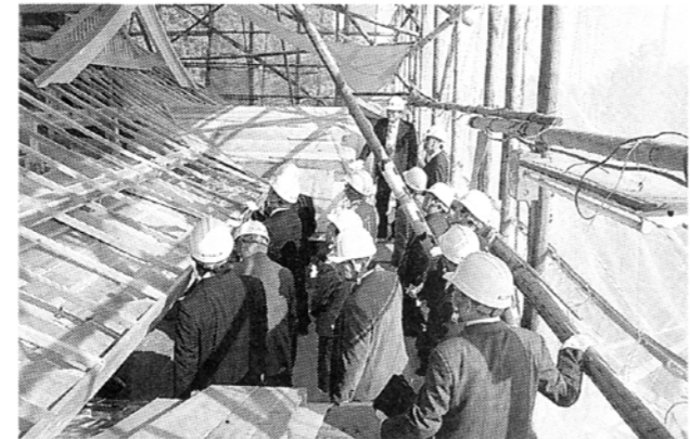
▲屋根葺替工事を見学（岡山）
