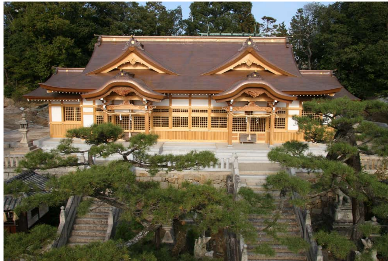
新しく建設された社殿正面 二つ並んだ向拝の唐破風と、その上の大屋根の千鳥破風が象徴的となり荘厳さを醸し出している 随神門上からバケット車にて撮影
