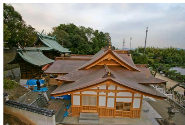
西側からの本殿との調和 バケット車にて撮影
