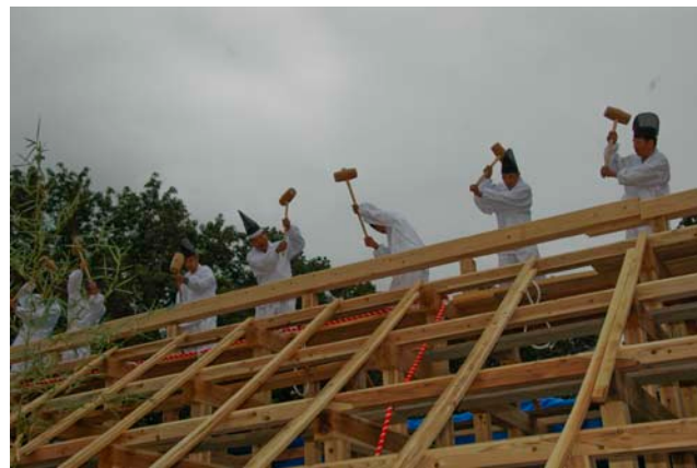
【槌打の儀】曳綱の儀で棟に上げられた棟木を棟梁の「千歳棟」、「万歳棟」、「永永棟」の掛け声と振り幣の合図で7名の工匠がカケヤで打ち付け棟木を設置した。
