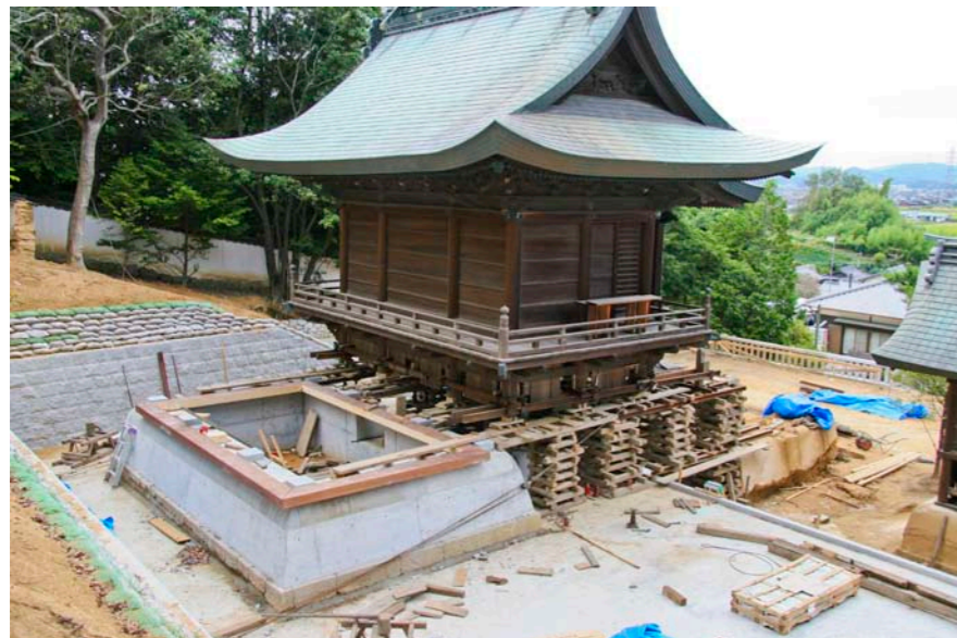
「曳家」により新しい亀腹に移動する鶴崎神社本殿
