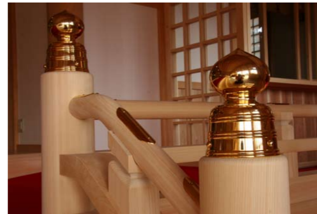
35高欄に取り付けられた擬宝珠と笹金具
