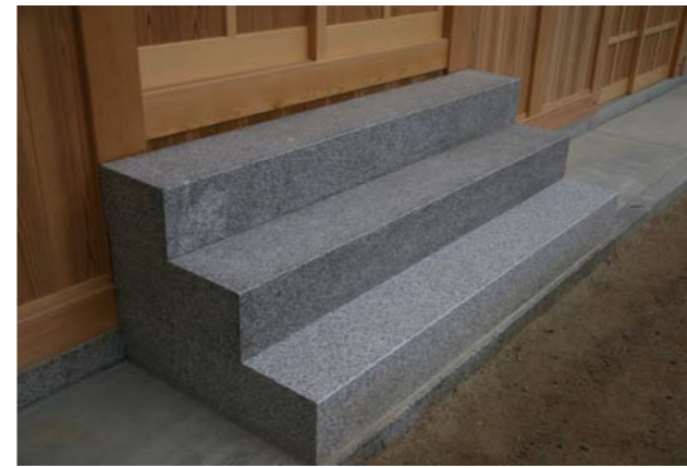
31予備室外側に設置された石段
