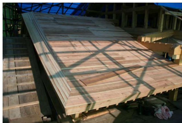
⑥⑩ 脇殿屋根に張られた屋根地板
