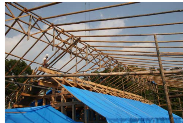
④⑩ 作業用の覆屋組み立て
