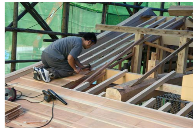
④⑥ 屋根の化粧板張り
