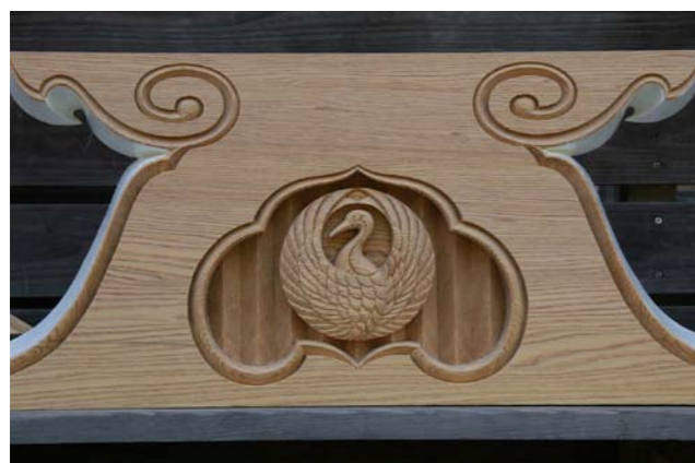
⑤④ 両殿の虹梁と桁の間に設置される前の蓐股 (かえるまた)
