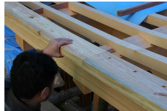
④⑤ 破風板の上に設置される松材の裏甲
