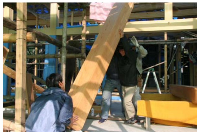
⑤⑤ 8寸5分の櫛の向拝柱設置
