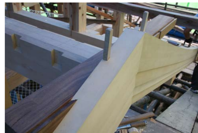
④⑨ 破風板 (ヒバ材) の接合部分
