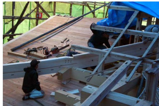
⑤③ 大屋根の軒を支える檜材の巨大な隅木
