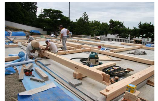
②⑨ 土台(木曾檜)設置
