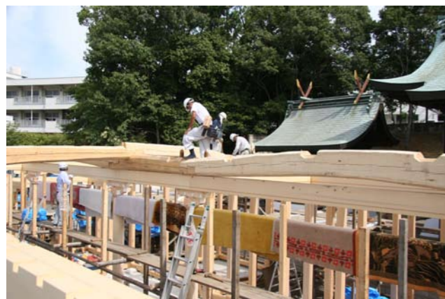
③⑧ 桁の上に松材の梁を取り付け
