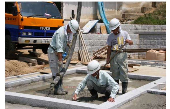
②⑤ 祭具庫コンクリート打設
