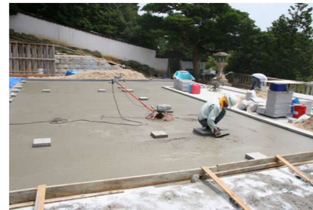
②⑥ 拝殿、幣殿コンクリート打設
