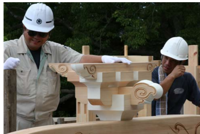
③⑤ 虹梁の両端に榼組を取り付け
