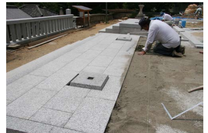
②⑦ 向拝板石張り
