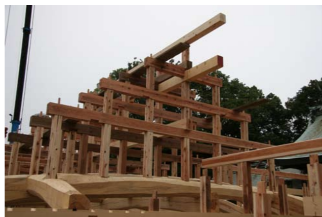
③⑨ 梁の上に組まれた杉とヒバの小屋組
