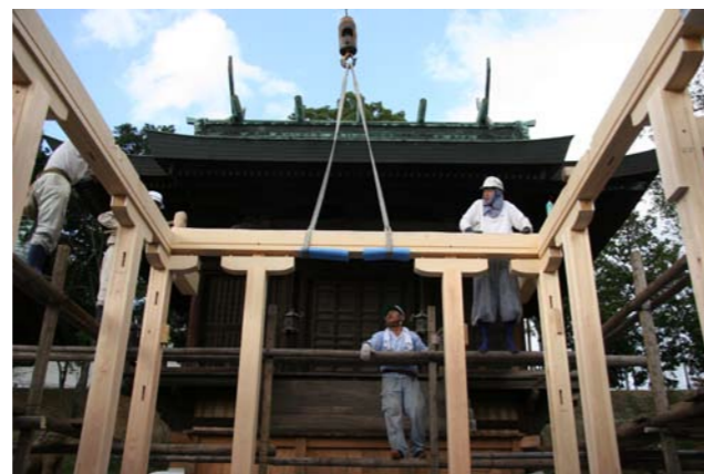
③⑦ 船肘木の上にヒバ材の桁を取り付け
