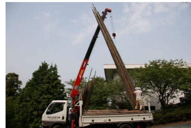
②⑧ 足場丸太搬入
