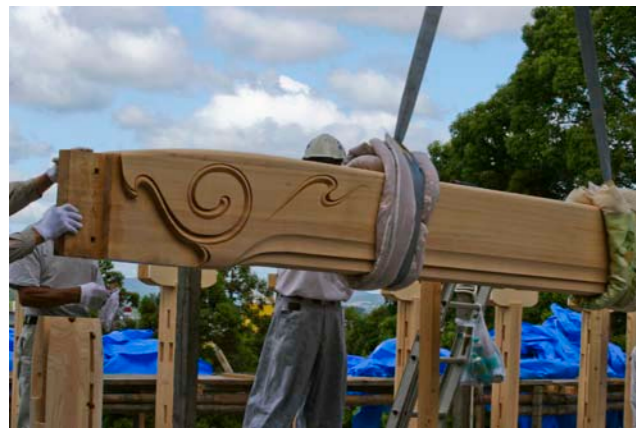
③④ 6mの羅白檜の虹梁を取り付け
