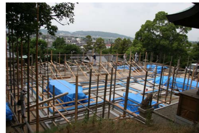
③⑩ 足場架設
