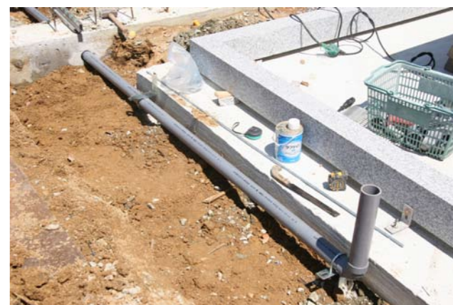
⑮水道配水管設置
