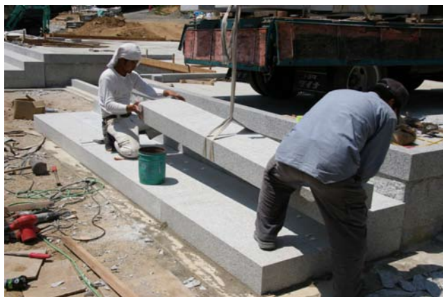
⑳向拝前面へ石段 (W4850 mm .H165 mm .D380 mm) 設置
