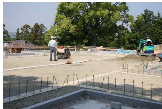
⑫社殿敷地へ碎石敷設
