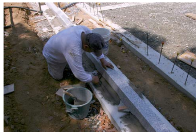
⑭犬走りの延べ石設置
