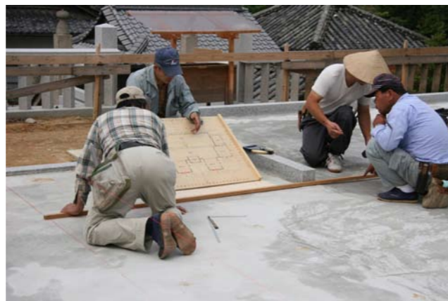
⑲地覆石設置場所への墨打ち
