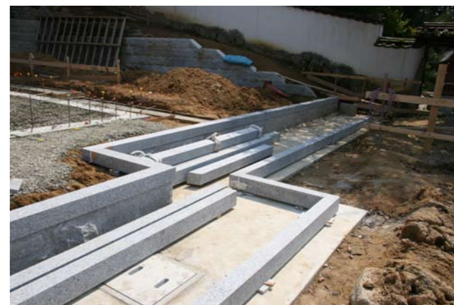
⑬雨落ち側溝の延べ石設置
