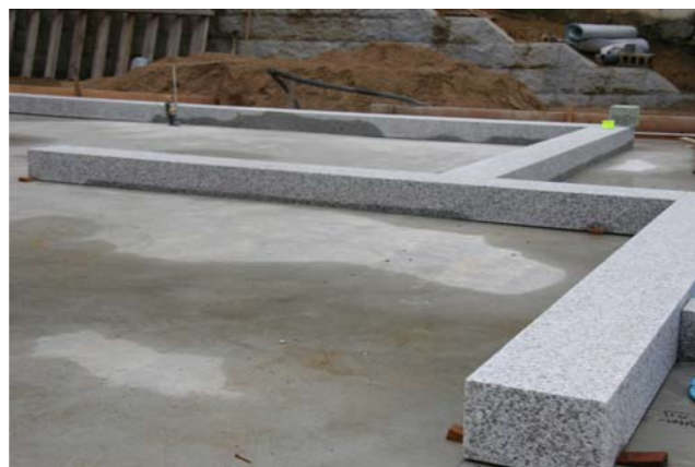
㉑社殿の地覆石設置
