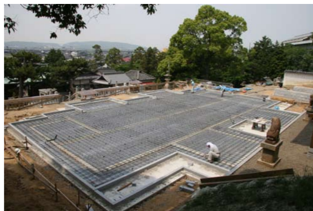
⑰社殿基礎全面へダブル鉄筋組み
