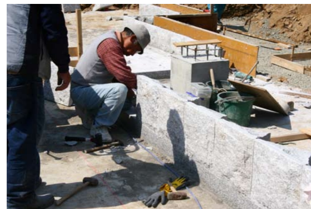
⑨社殿前面へ間知石設置
