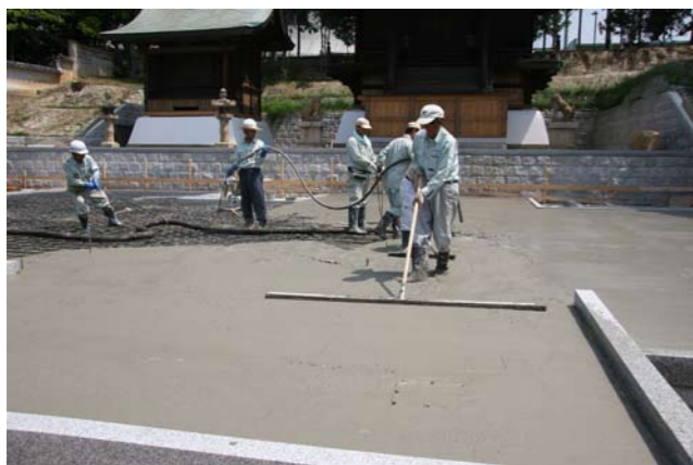
⑱鉄筋組みの上へコンクリート打設
