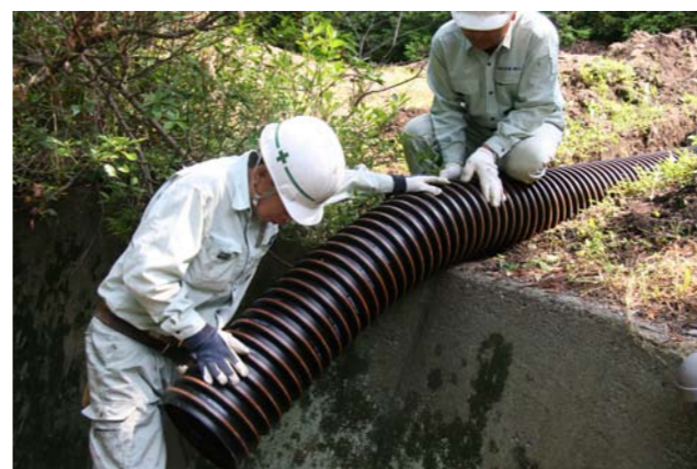
⑯溜め枡から境内下段への配水管埋設
