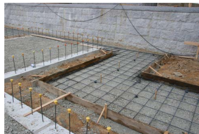
⑪雨落ち側溝鉄筋敷設
