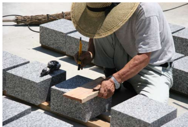
㉓社殿柱石(土台敷き石)設置
