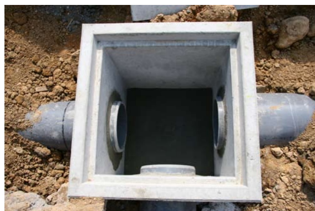
⑥排水溜め枘設置
