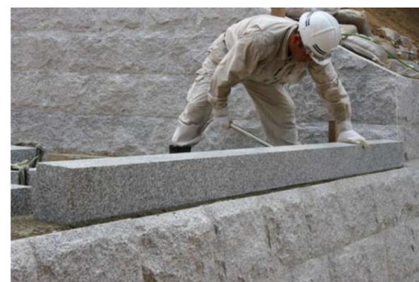
15 両本殿移設地前擁壁の上に延べ石設置
