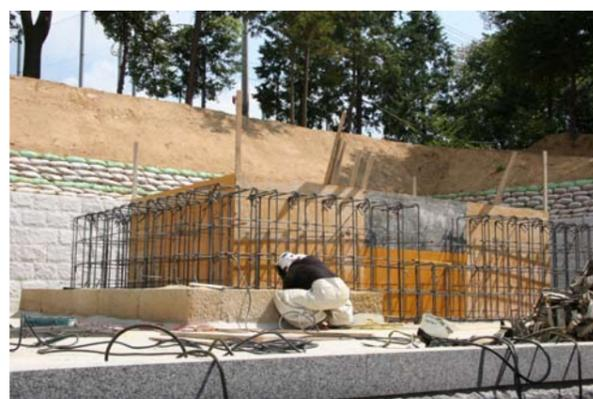
23 鶴崎神社本殿亀腹鉄筋、型枠組み
