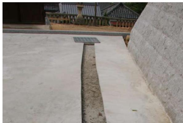
16 両本殿移設地排水の溝切り
