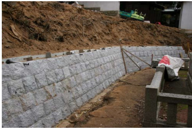
② 進入路擁壁石積み
