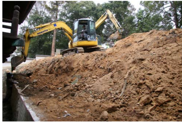
③ 両本殿移設地掘削
