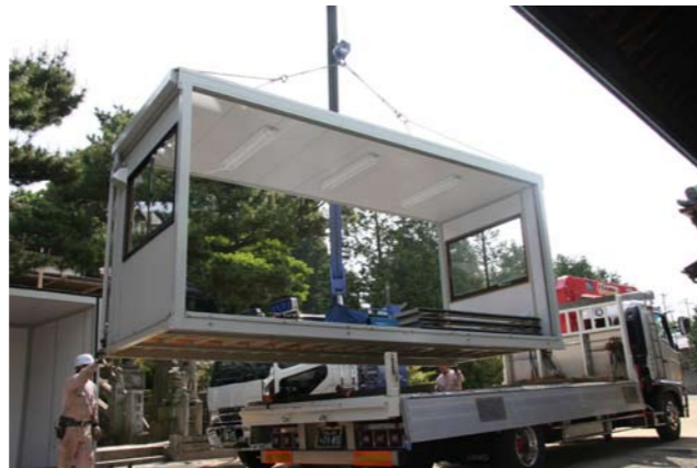
⑦ ユニットハウスの仮拝殿設置
