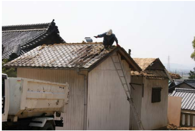
④ 倉庫2棟解体
