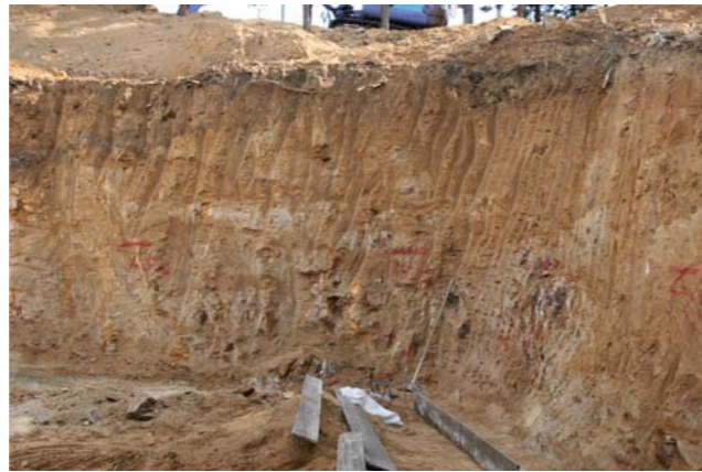
⑤ 両本殿移設地奥擁壁基礎
