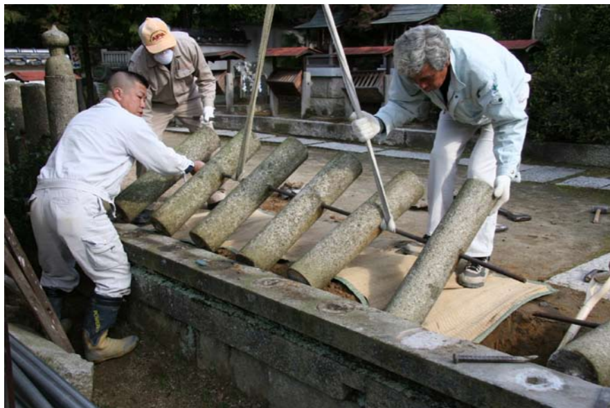
修理のため台座石から外される玉垣
