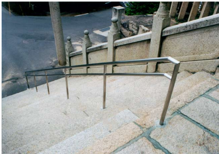
新たに設置されたステンレス製の手摺り
