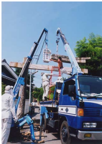
社号額設置作業
